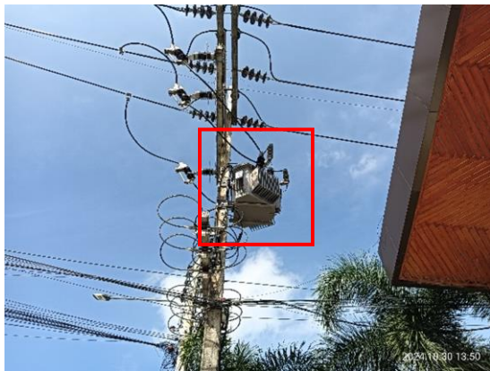
รูปที่ 3-10 หม้อแปลงไฟฟ้า
